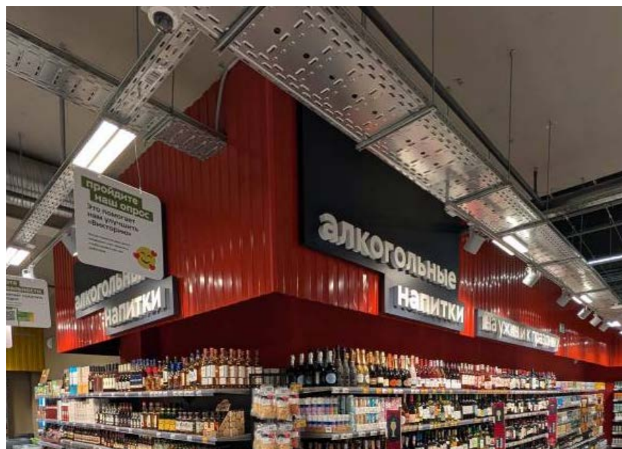
В углах фризы не прерываются, а соединяются, повторяя геометрию стен
