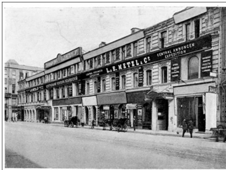
Рис.1. Здание конторы Л. и Е. Метцель
